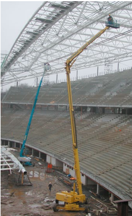
Bild 6-2: Hubarbeitsbühne im Baustelleneinsatz
