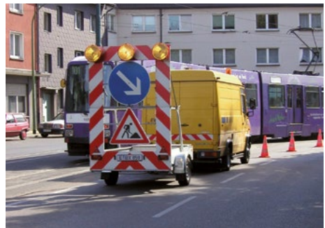
Bild 4-8: Sicherung gegen Gefährdungen des öffentlichen Straßenverkehrs
